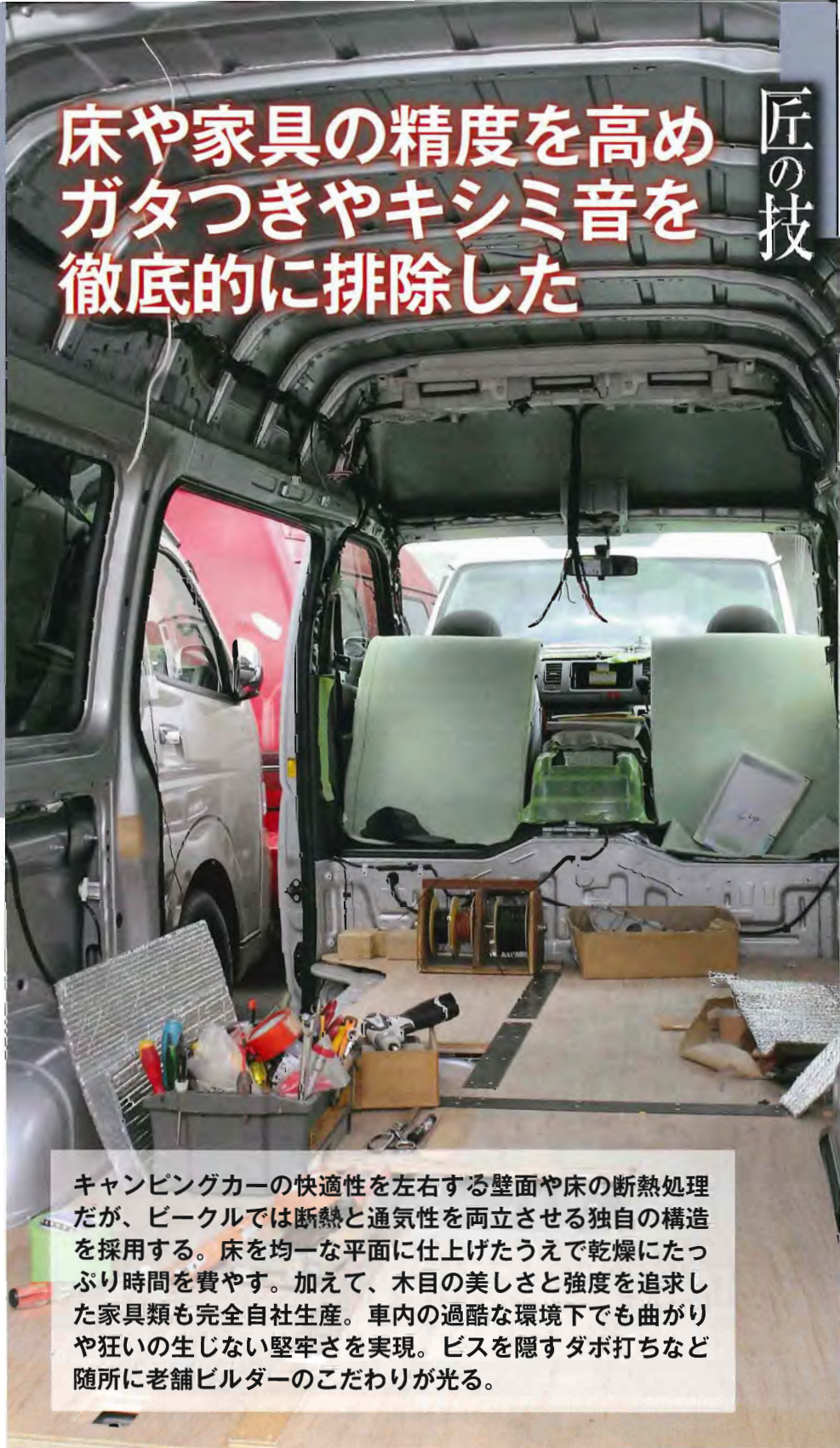
家具を据え付けるための平滑な土台作りは、ピークルがもっともこだわるポイント。専用の水平ゲージを使い、凹凸のあるフロアに床材をセメントボンドで接着。この際、サビの原因となるビス止めは一切施さない。木材は工作機械で切り出すのでキッチリ直線になるが、季節別の湿度差に合わせて、組み付ける際に平面が出るように微調整する。
